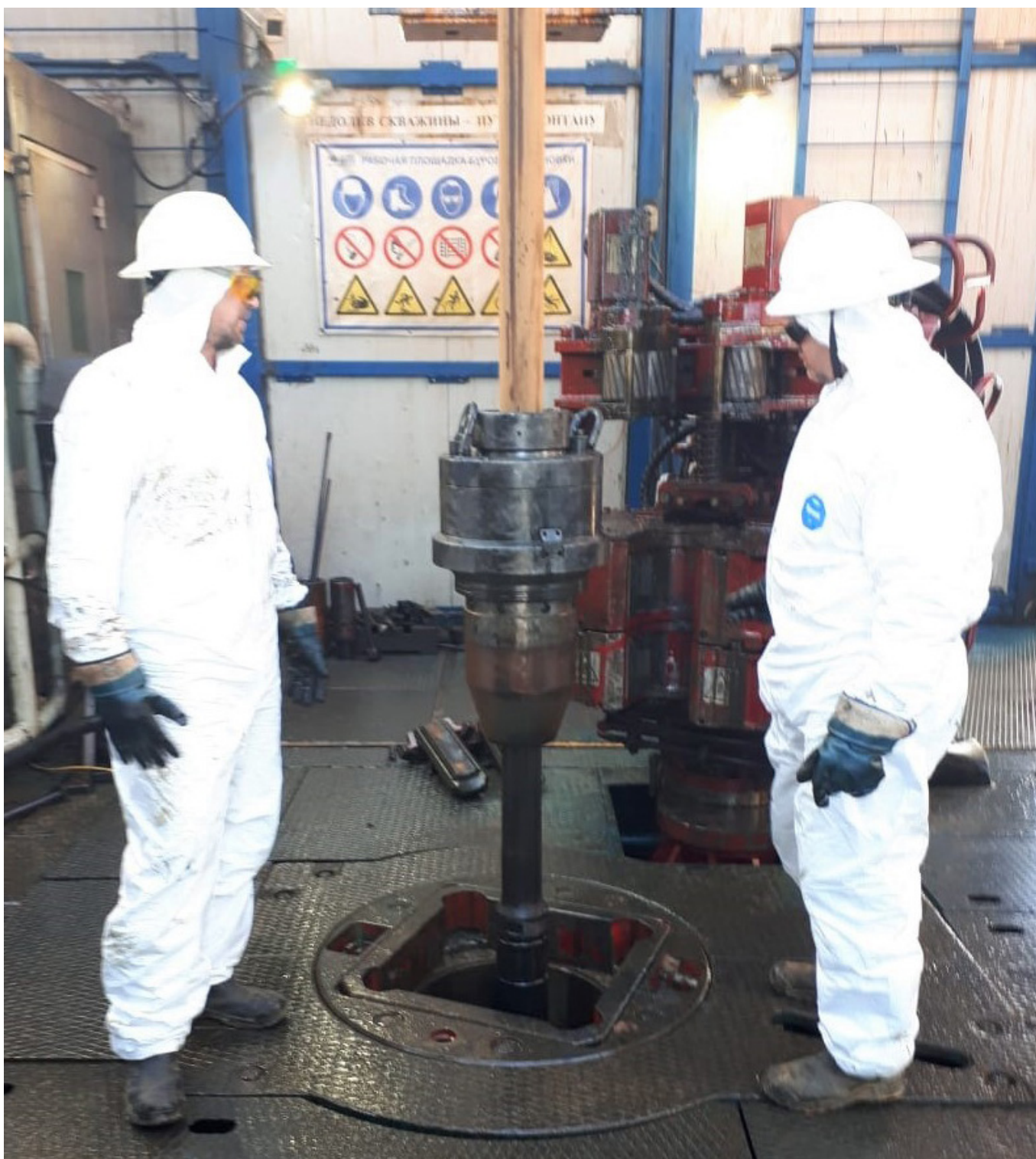
Монтаж оборудования для выполнения бурения с регулируемым давлением на КП-8. Куломбинский лицензионный участок
