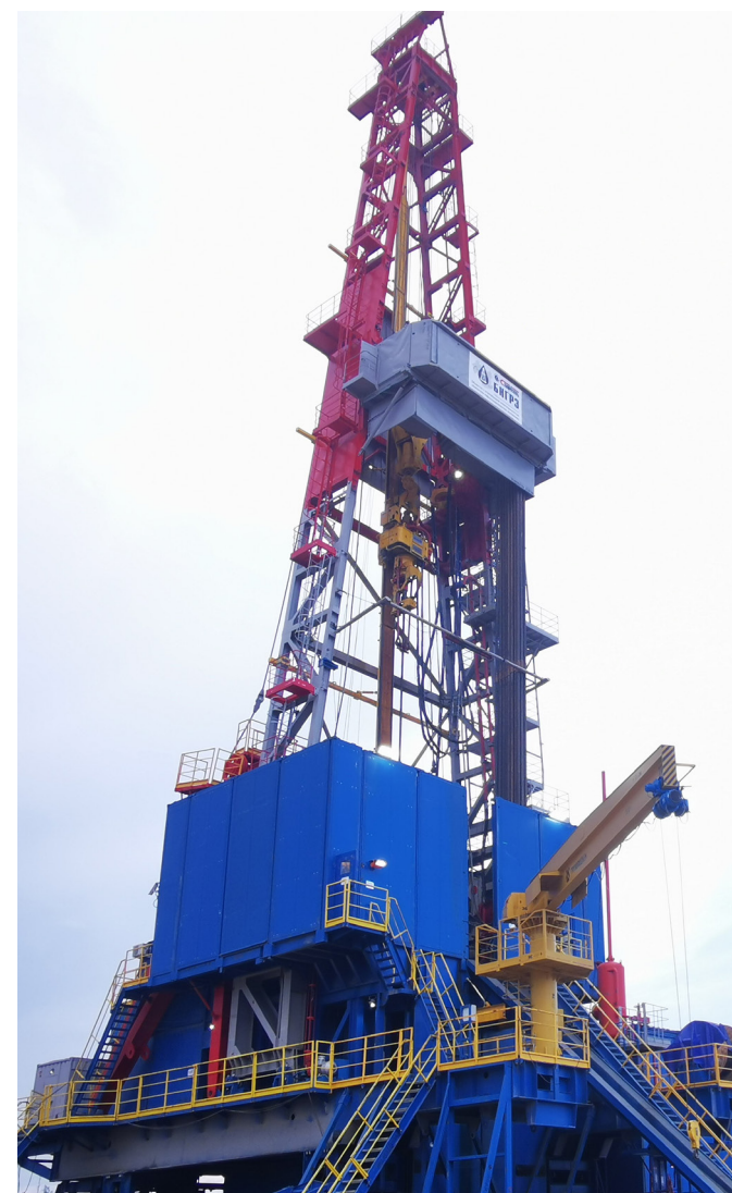
Буровая установка ООО «БНГРЭ» на Куюмбинском лицензионном участке
